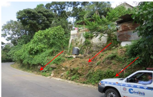
Vivienda en zona de riesgo por deslave.
