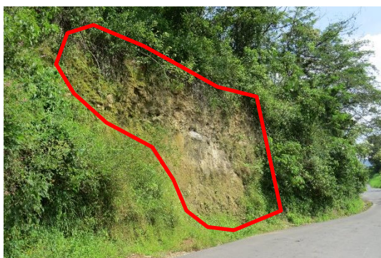
Zonas de deslizamiento de suelos carretera Acayotla-Córdoba.
