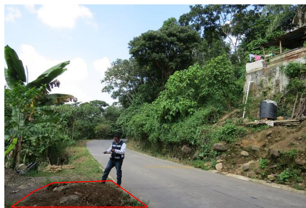
Zona que ha aparentemente ha sido rellenada, zona de deslizamiento de suelo.
