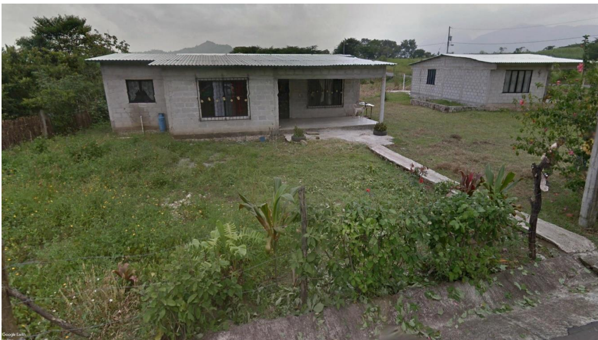
Casas vulnerables a destechamiento por viento en la localidad de Acayotla.
