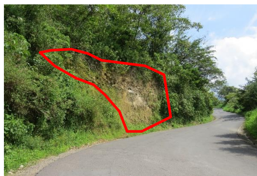
Zonas de deslizamiento de suelos carretera Acayotla-Córdoba.
